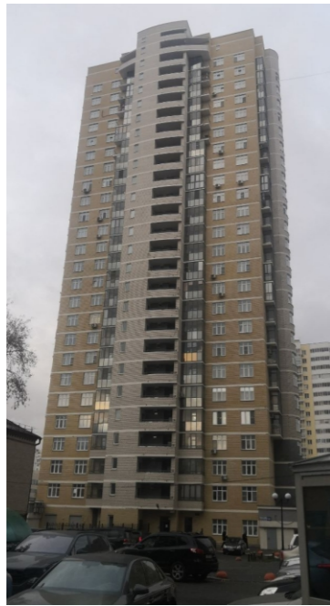
Дворовой фасад (Вид С)
